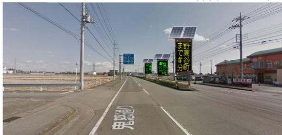
表示機は約20mおきに3機設置し、1機目は柳田大橋経由、2機目は板戸大橋経由、3機目は新鬼怒橋経由で国道408号バイパス交差点までの平均所要時間を表示する予定で、混雑状況を見て迂回していただき、交通量の平準化を図るものです。
