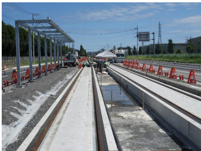
<芳賀台交差点から管理センター方向>
