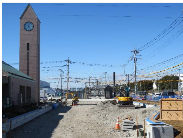
<工事が進む芳賀トランジットセンター>
